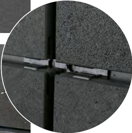
SISTEMA A SCOMPARSA Hidden anchor system Système non apparent Unsichtbare Befestigung Sistema oculto Скрытая система
